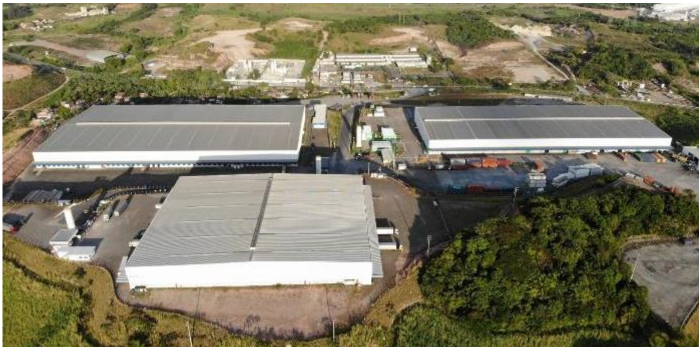
Imagem 3: Foto Aérea dos Galpões
