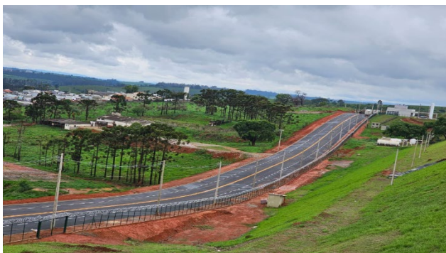
Foto da nova avenida com sinalização recém executada.
