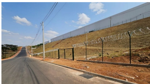
Fotos da nova avenida com instalação do gradil.
