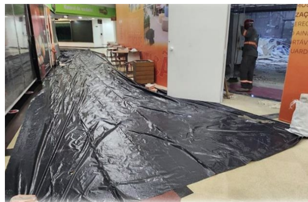
Tapume de isolamento da obra e proteção para retirada de entulho.
