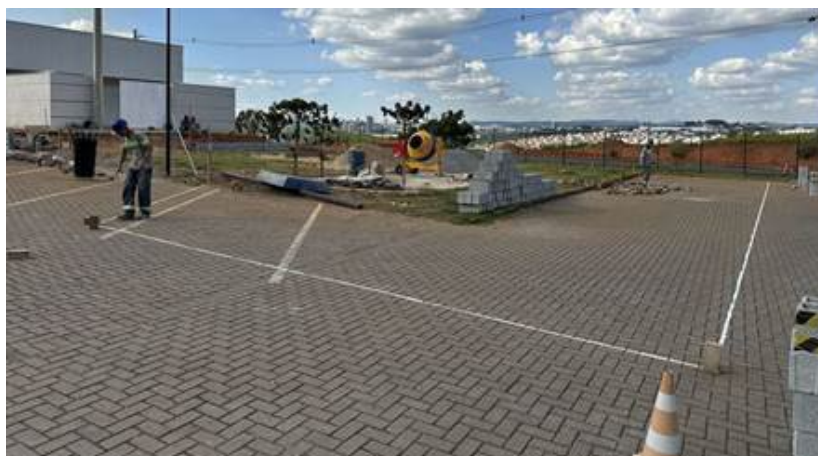
Foto obra carga e descarga do restaurante no Citlog Sul de Minas.
