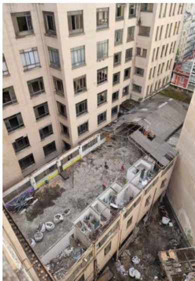
Início da demolição do galpão (ago-set/23)
