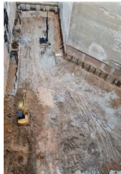
Contenções e escavação (jan-fev/24)
