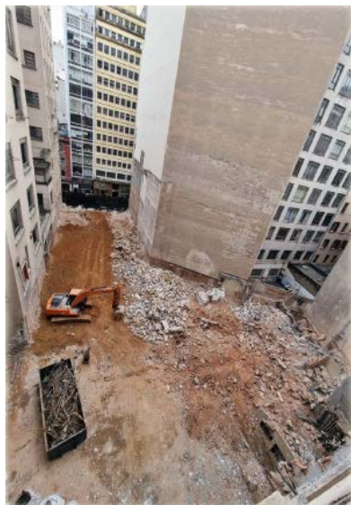
Galpão demolido | limpeza e remoção de entulhos (out/23)
