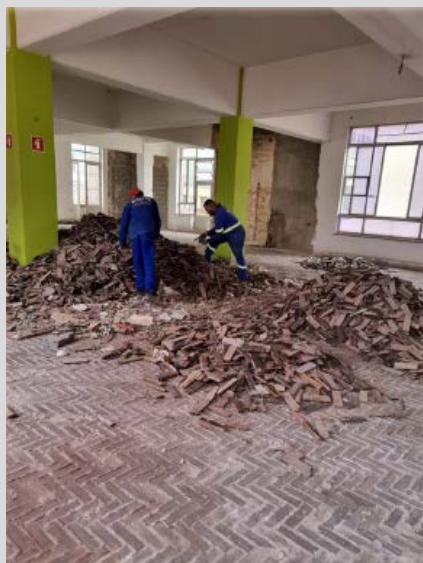
Remoção de tacos dos pavimentos (out-23)
