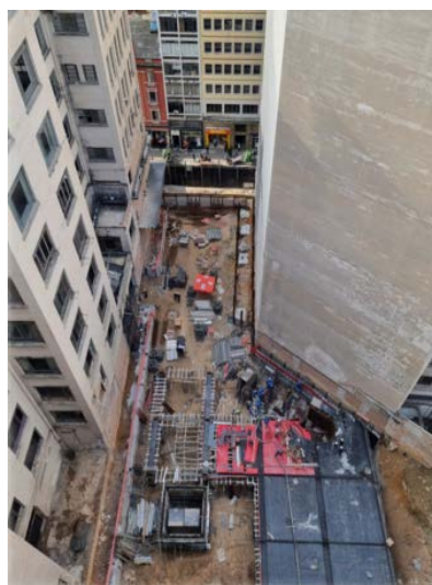
Concretagem superestrutura (mai-jun-jul/24)
