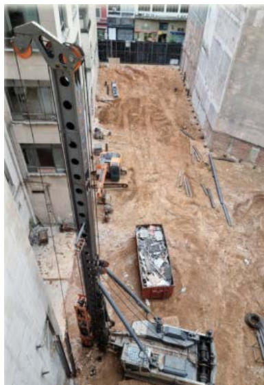
Execução do Perfis Metálicos das contenções (nov/23)
