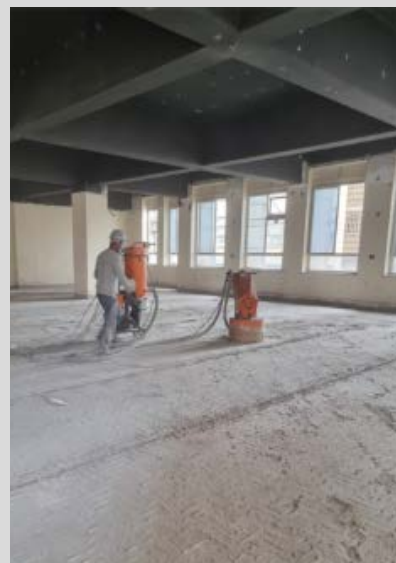
Lixamento do contrapiso (jan/24)
