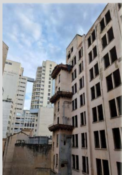
Remoção de Caixilhos e elementos de fachada | bloco B (nov/23)
