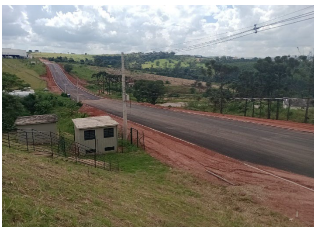
Fotos da via em obra.
