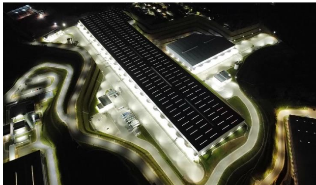
Execução de obras – Foto Panorâmica
