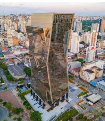
São Paulo, SP Edifício Faria Lima Plaza
