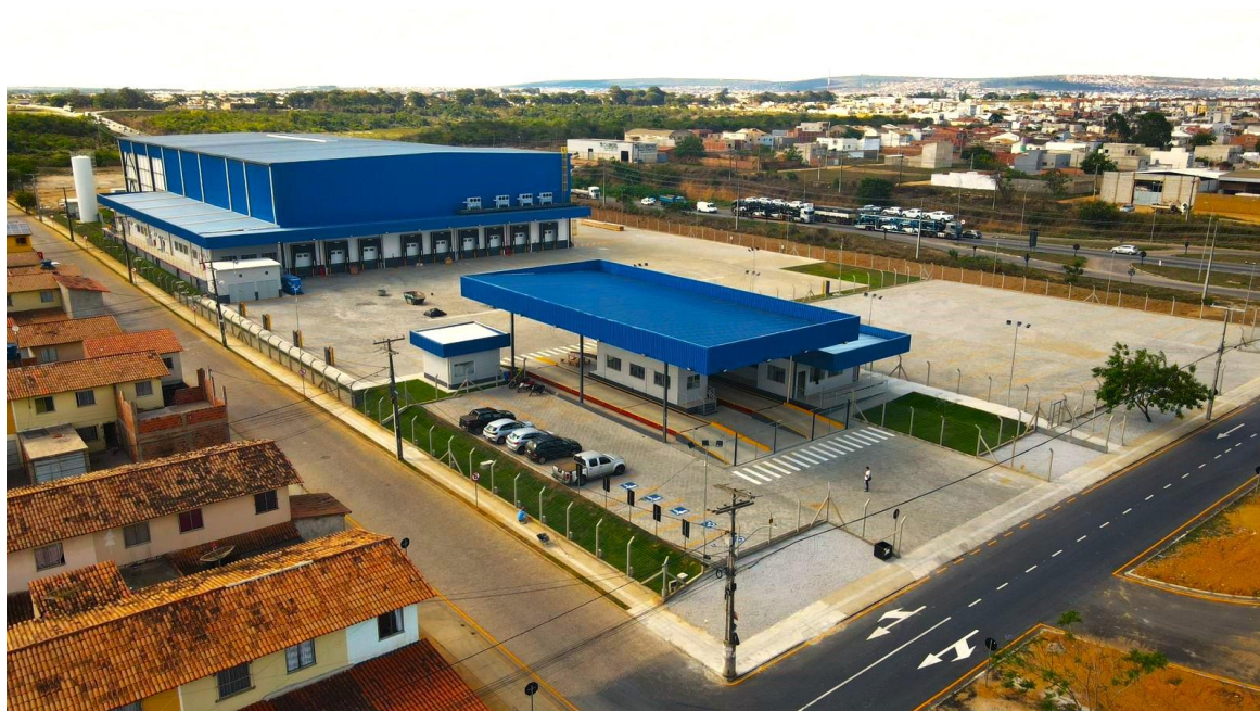
Execução de obra Seara VDC/BA – Foto Panorâmica
