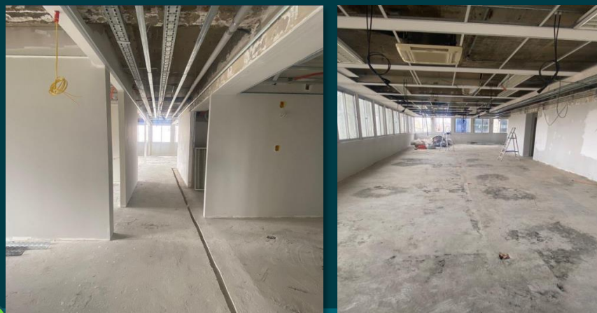
Status atual da obra (5ª semana)
