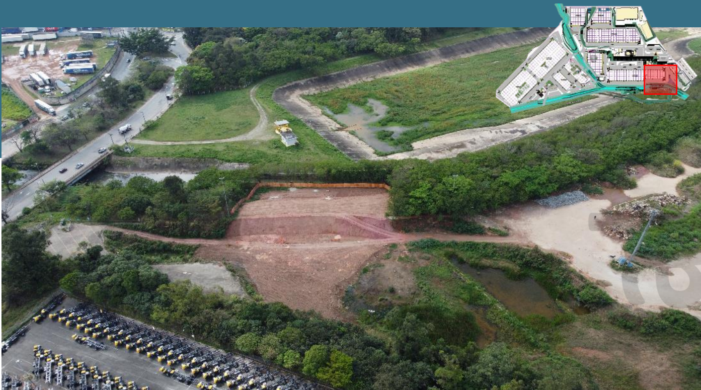
FZ-01 – Pátio Vietnã, escavação complementar, 15/09/2023
