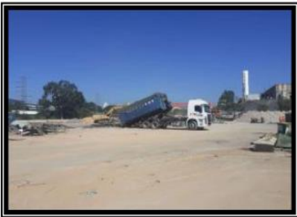
Remoção de entulho - prédio antigo 56
