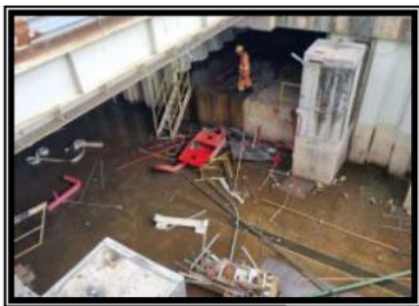
Limpeza dos pits.
