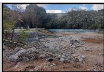
Conclusão da ETE - área Tetra Tech
