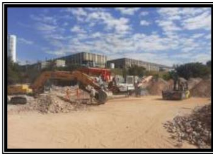
Britagem do material
