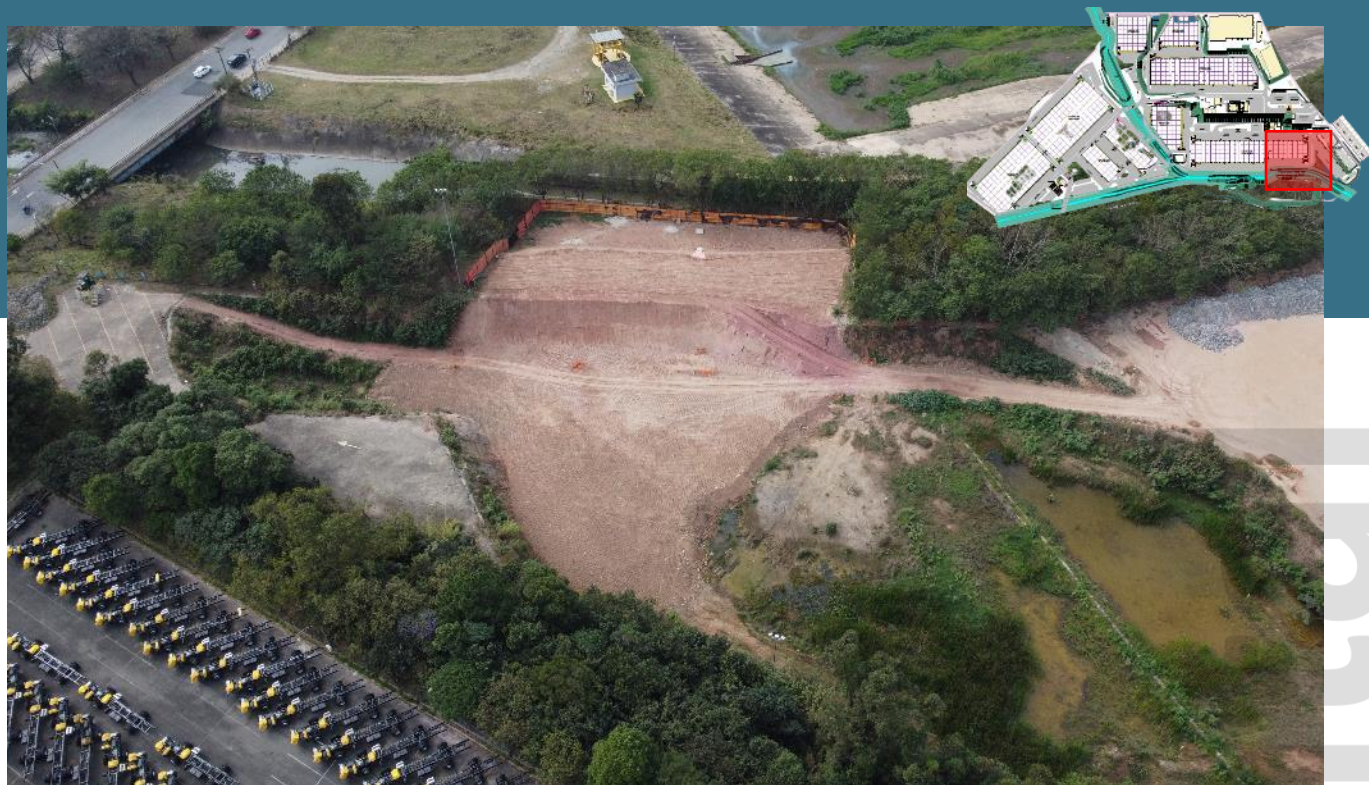
FZ-01 – Pátio Vietnã, escavação complementar, 16/08/2023
