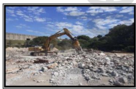
Segregação do entulho
