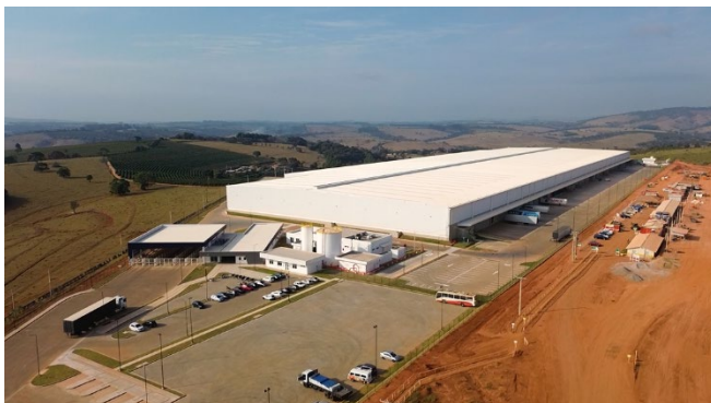
Visão geral entrada do condomínio com portaria e áreas comuns.
