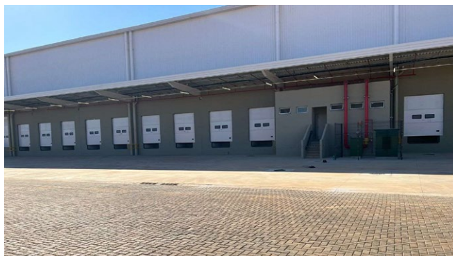
Docas e sanitários do galpão.
