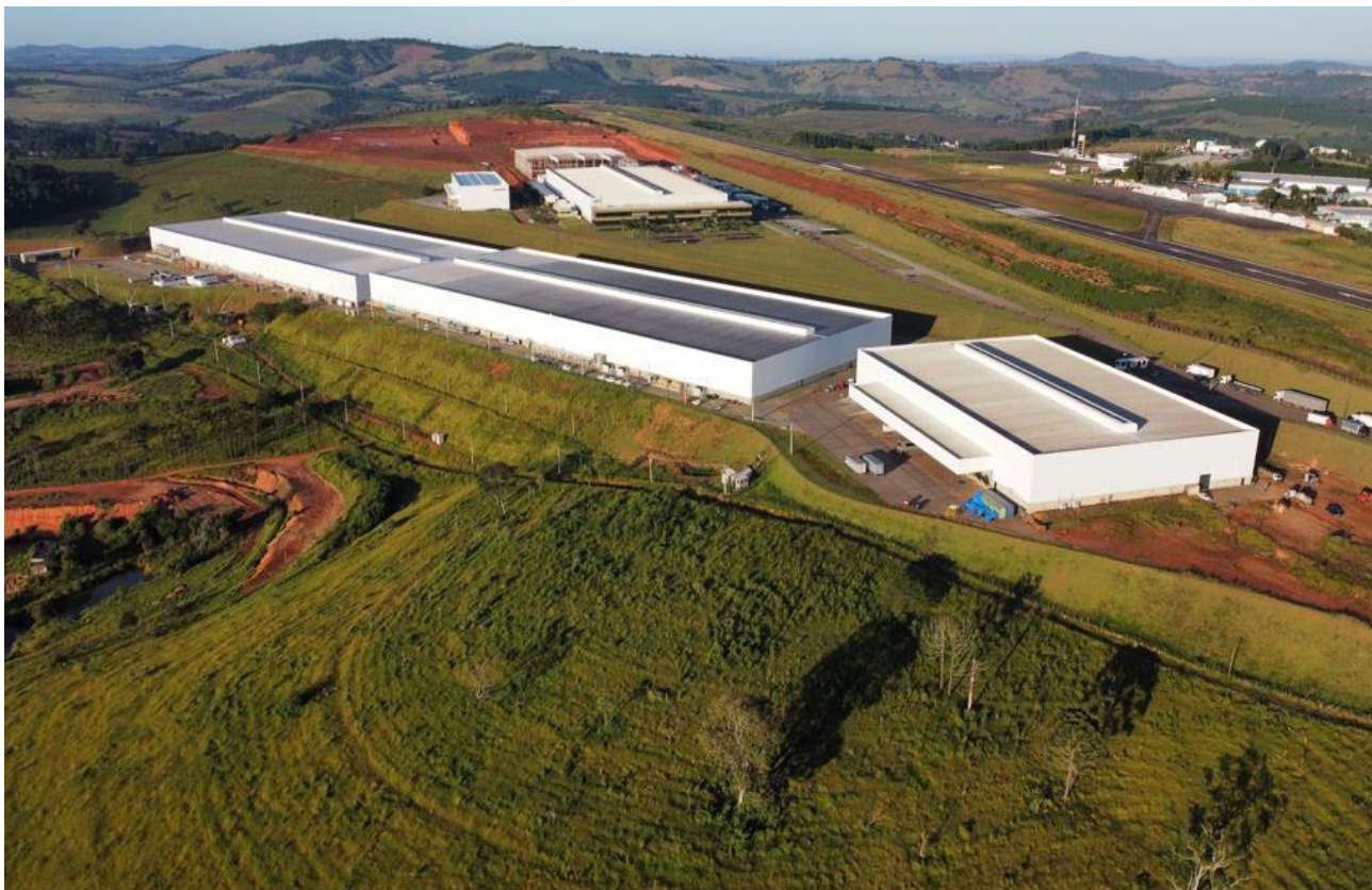
Foto aérea do Citlog Sul de Minas.
