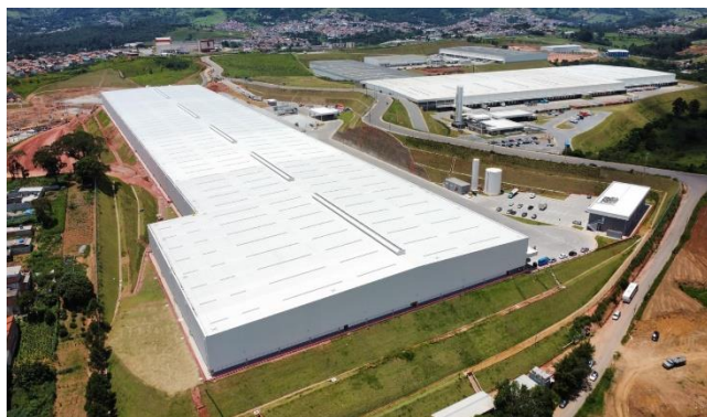
Execução de obras – Foto Panorâmica
