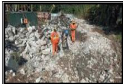
Remoção da demolição - tanque ETE
