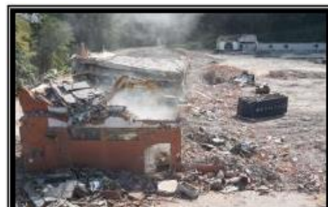
Demolição de alvenaria - antigo prédio 56.
