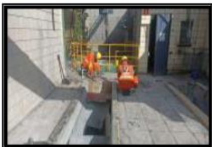
Remoção do piso de borracha - antigo prédio 119
