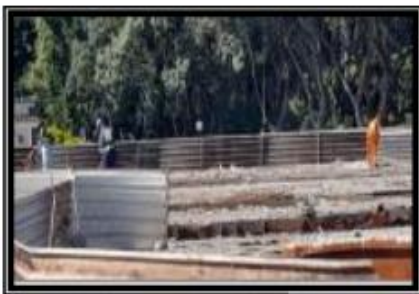
Instalação de proteção nos pits.
