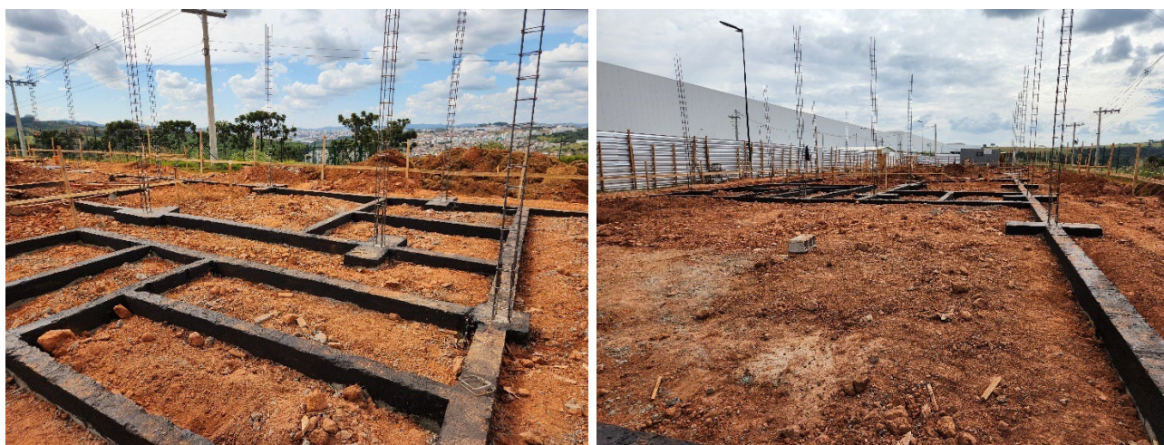
Foto obra restaurante Citlog Sul de Minas.
