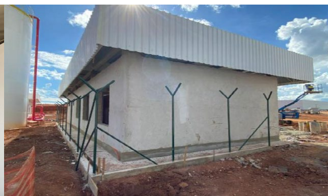
Área de Apoio aos Motoristas e gradil perimetral.
