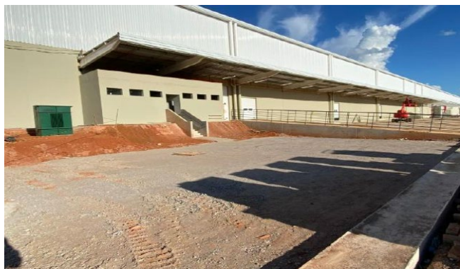
Fachada, docas e sanitários anexos Módulo 1.
