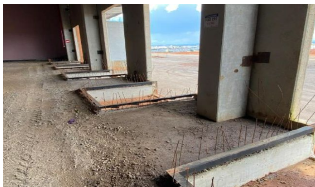
Base de piso e execução de nichos de niveladoras de docas Módulo 6. Preparo de base de piso e execução de fundações mezanino Módulo 13.
