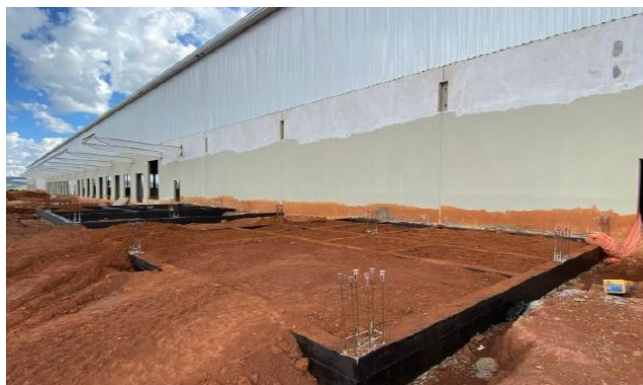
Fundação, blocos e baldrames Núcleos anexos Módulos 6 e 8.
