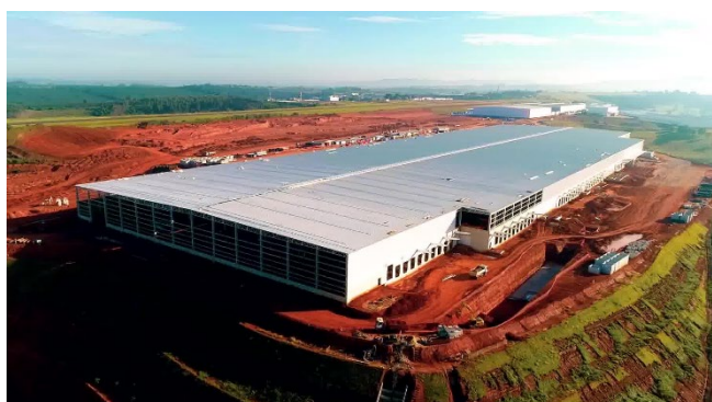
Visão geral do fundo condomínio.
