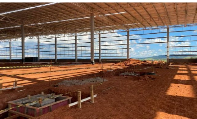
Base de piso e execução de nichos de niveladoras de docas Módulo 6. Preparo de base de piso e execução de fundações mezanino Módulo 13.
