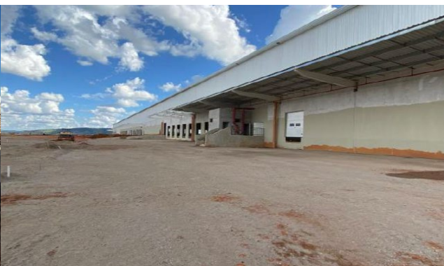
Fachada, docas, e sanitários anexos Módulos 4 e 6.
