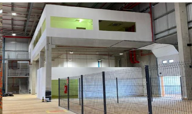
Mezanino e gradil BTS Marelli.
