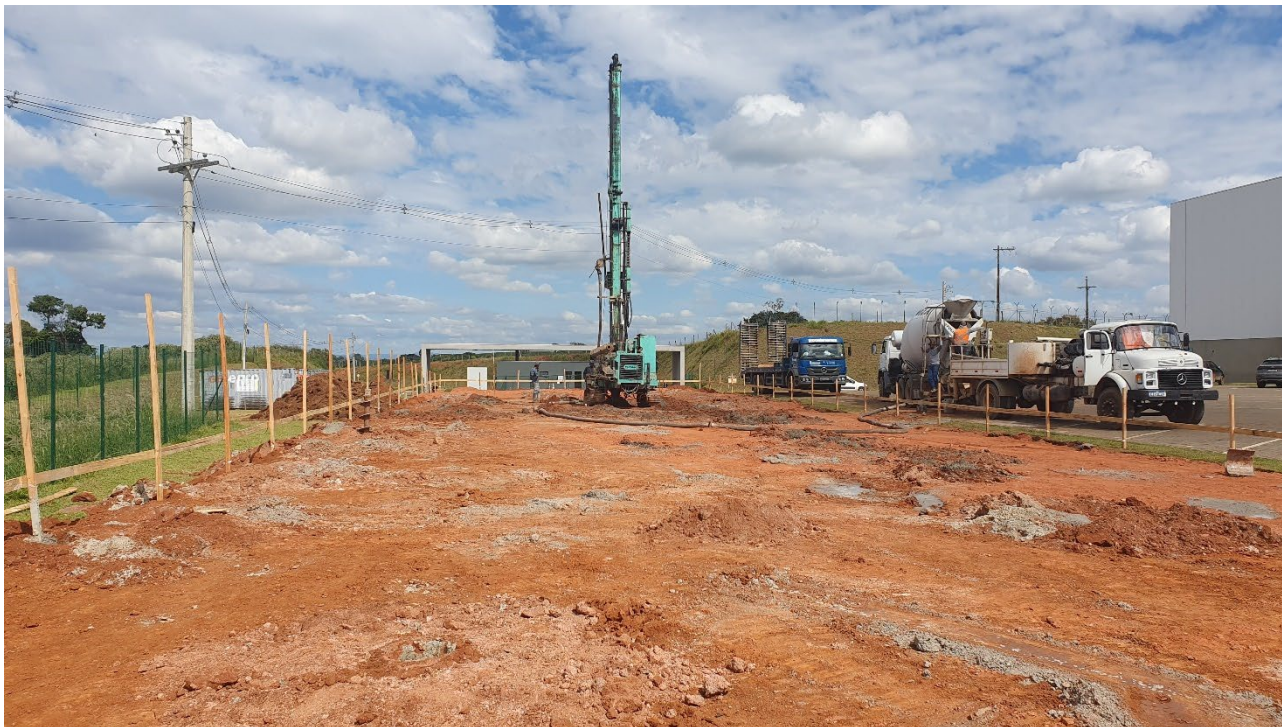
Foto obra restaurante Citlog Sul de Minas.
