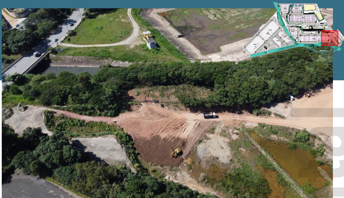
FZ-01 – Pátio Vietnã, escavação complementar, 15/05/2023
