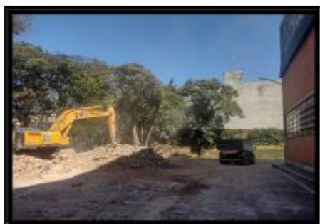
Demolição alvenaria/ concreto - antigo prédio 17/18.
