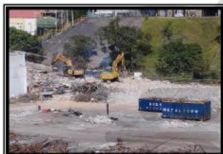
Demolição de alvenaria - antigo prédio 56.
