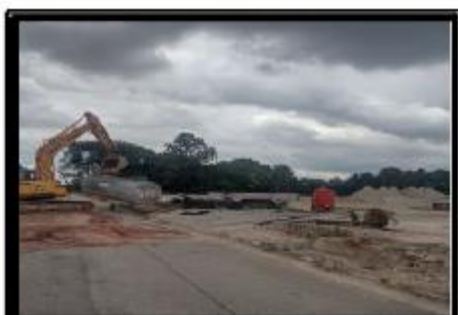
Remoção do tanque
