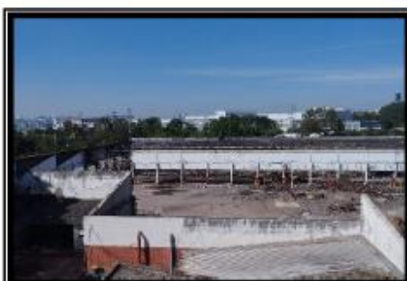
Vista geral - antigo prédio 56.
