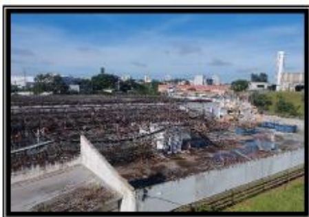
Remoção da estrutura metálica de cobertura - antigo prédio 56.
