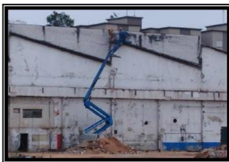
Demolição de alvenaria - antigo prédio 42.
