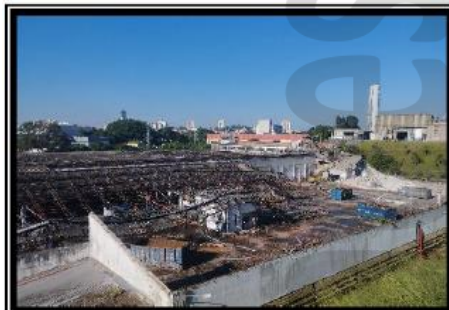
Remoção de estrutura metálica - antigo prédio 56.
