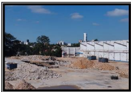
Vista geral - antigo prédio 42.
