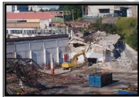
Vista geral - antigo prédio 56.
