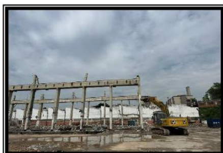
Demolição - antigo prédio 36.
