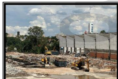
Demolição de alvenaria - antigo prédio 42.
