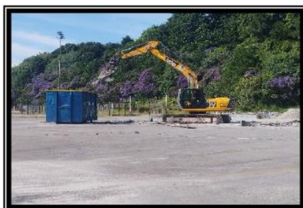
Remoção de sucata.
