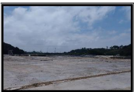
Vista geral - antigo prédio 70.
