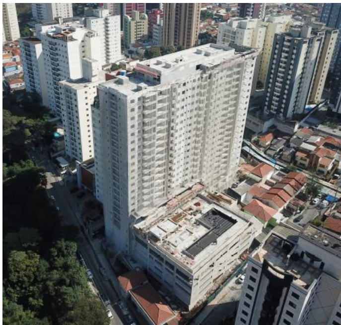
Foto Vista Geral Obra
