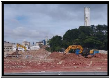
Limpeza da área - antigo prédio 33
