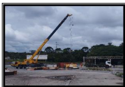
Remoção de estrutura metálica - antigo prédio 70
