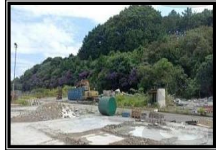
Demolição - antigo prédio 79/129
