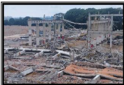
Vista geral em demolição - antigo prédio 36
