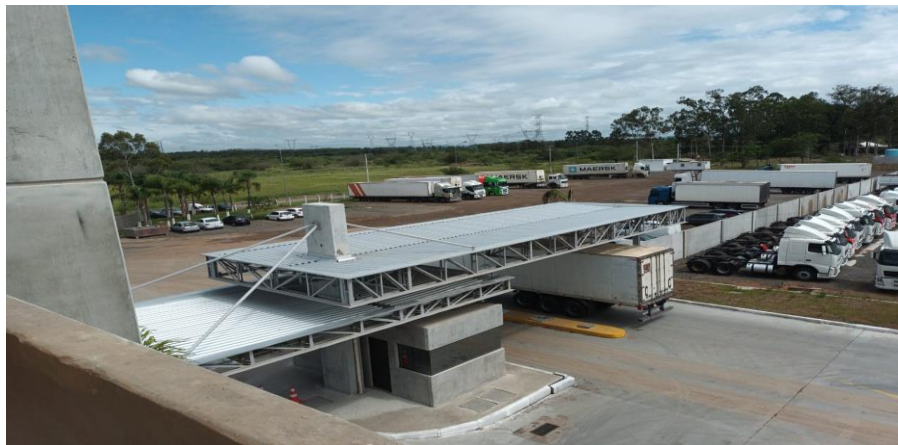
Entrada do Galpão logístico
