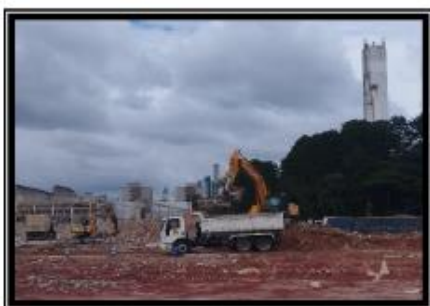
Vista geral - antigo prédio 33
