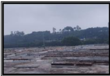
Vista geral - antigo prédio 70
