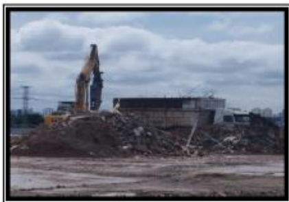
Remoção de sucata
