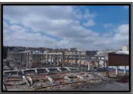
Demolição - antigo prédio 36
