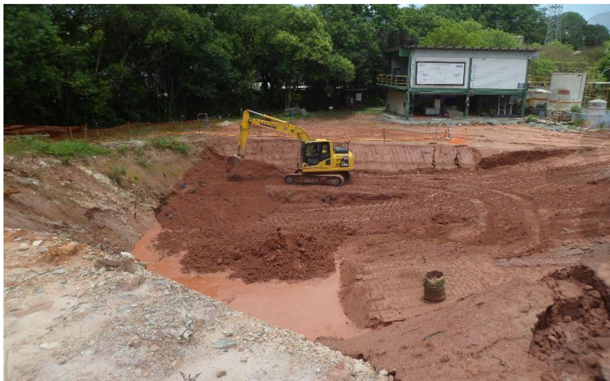
Vista do local em escavação, 15/12/2022
