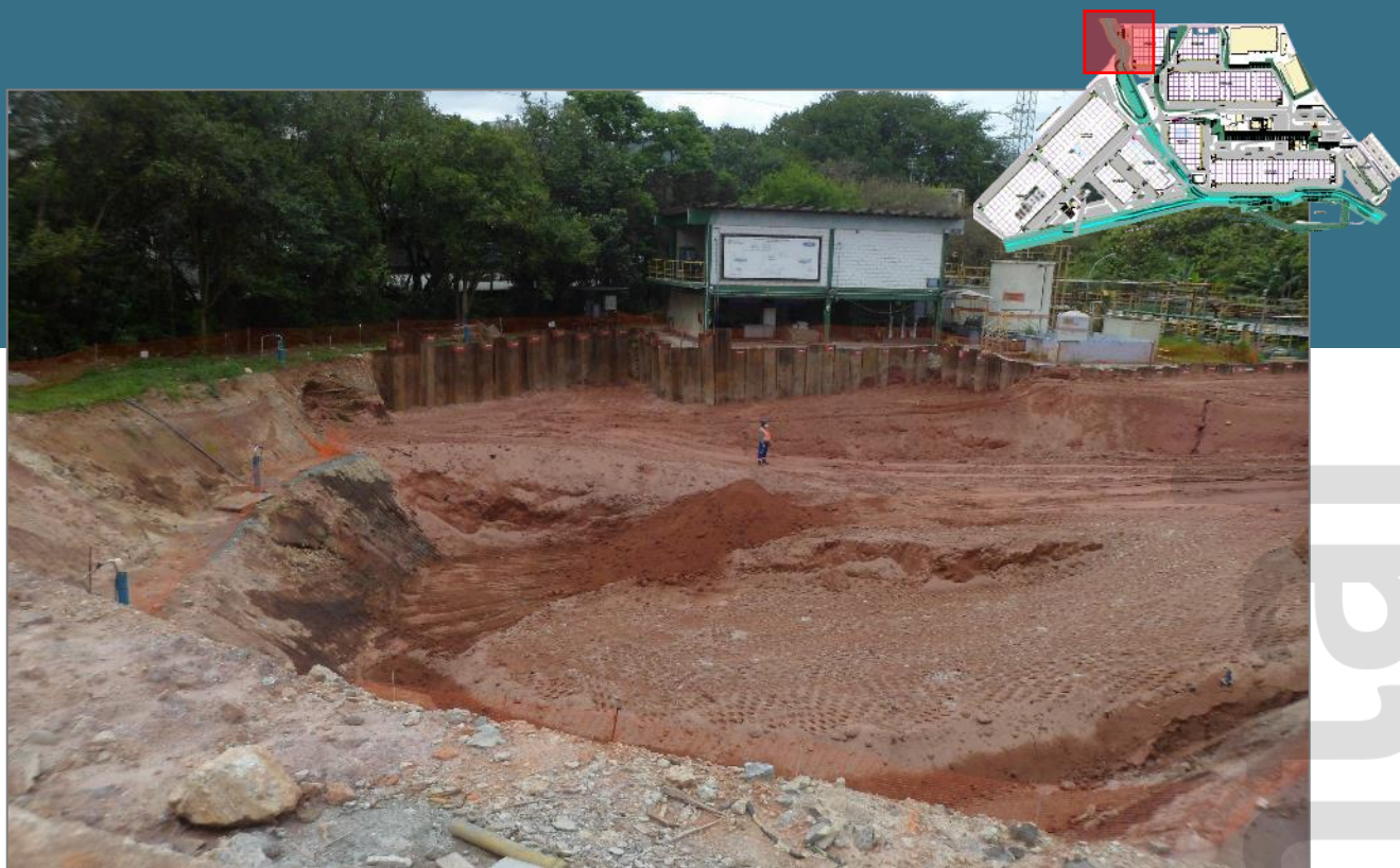
Vista do local em escavação, 07/11/2022
