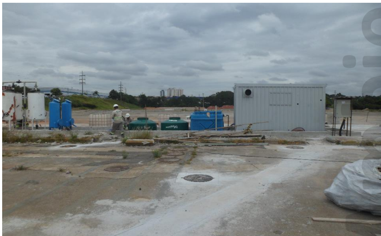
Equipamentos do sistema de remediação sendo instalados, 19/12/2022
