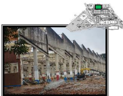
Demolição de alvenaria/ concreto - antigo prédio 36
