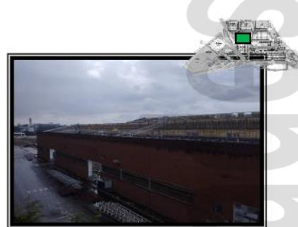
Remoção de estrutura metálica - antigo prédio 36
