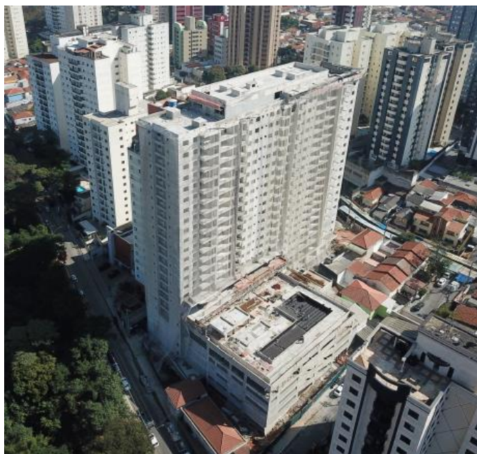
Foto Vista Geral Obra
