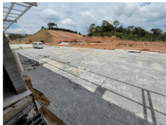
Pavimentação externa, piso intertravado
