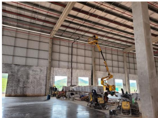
Instalação do sistema de combate a incêndio
