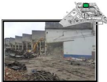
Demolição de alvenaria/ concreto - antigo prédio 36
