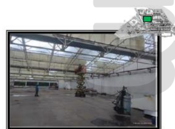
Remoção de estrutura metálica - antigo prédio 33
