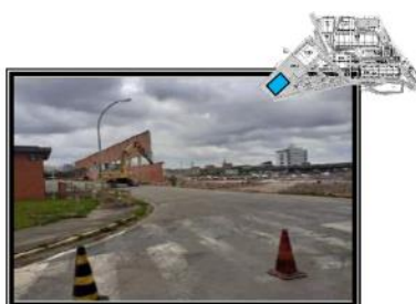
Demolição de alvenaria - antigo prédio 93
