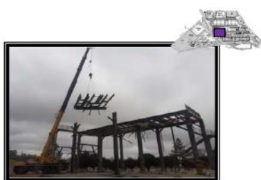
Remoção de estrutura metálica - antigo prédio 70
