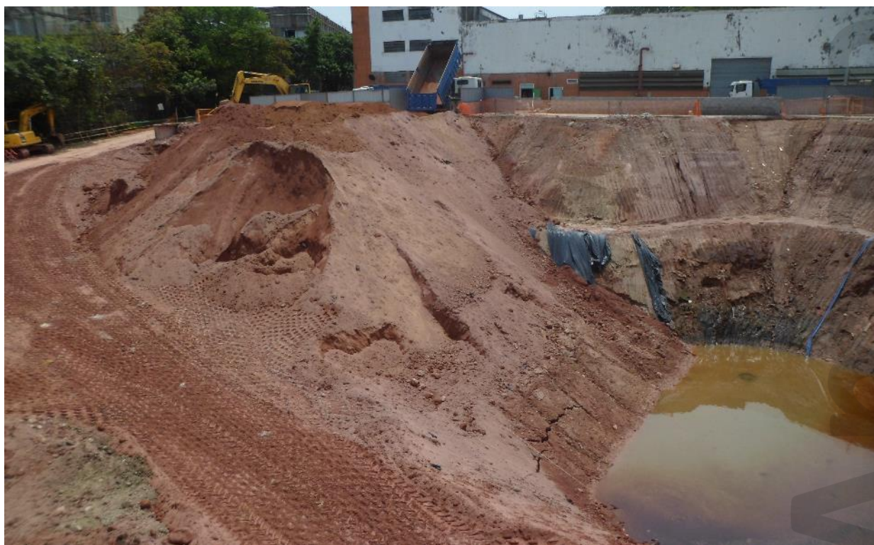
Vista do local em escavação, 17/10/2022
