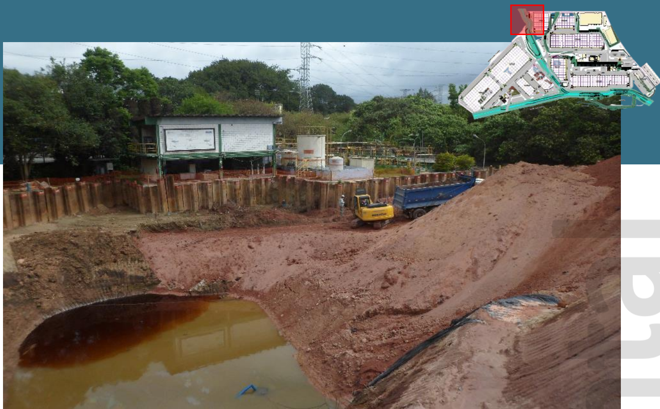
Vista do local em escavação, 14/10/2022
