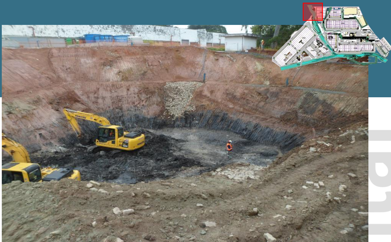
Vista do local em escavação, 09/09/2022
