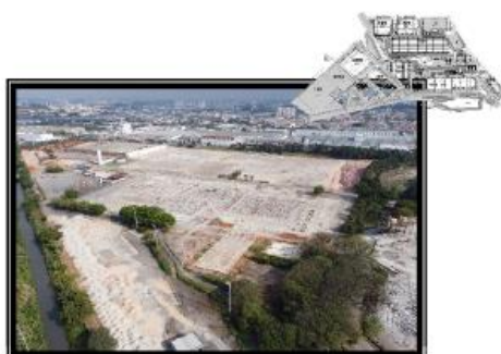
Vista geral - Etapas I e II
