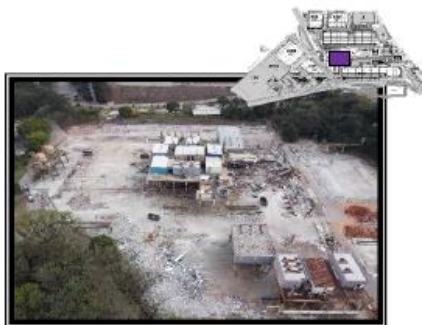
Demolição mecanizada - antigo prédio 70
