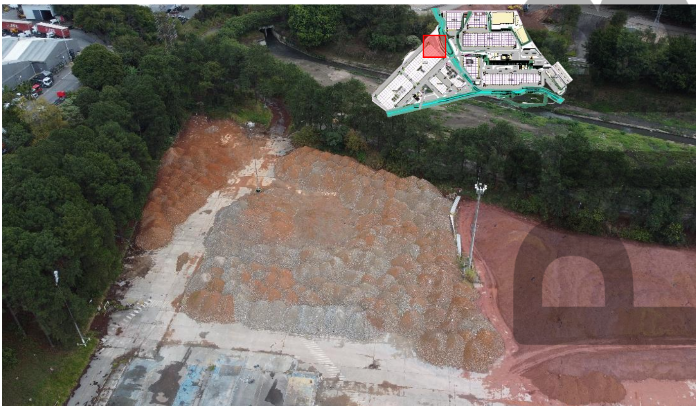
Estoque próximo ao futuro G200, 15/09/2022
