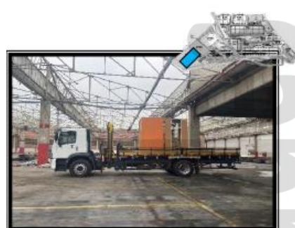
Remoção das subestações 93A e B - antigo prédio 93
