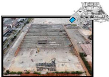
Demolição metálica - antigo prédio 93
