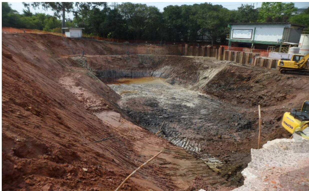
Vista do local em escavação, 09/09/2022
