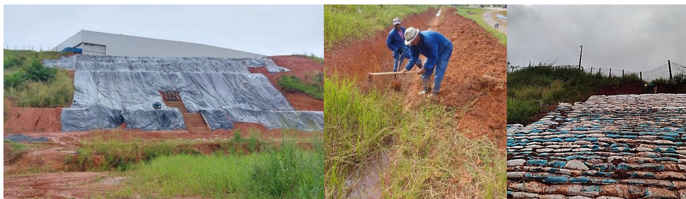
Imagem 6: Reparos no Talude
