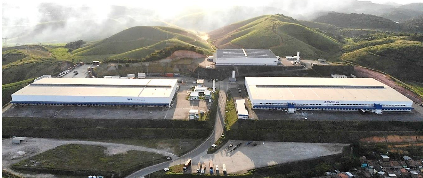
Imagem 1: Foto Aérea do Imóvel
