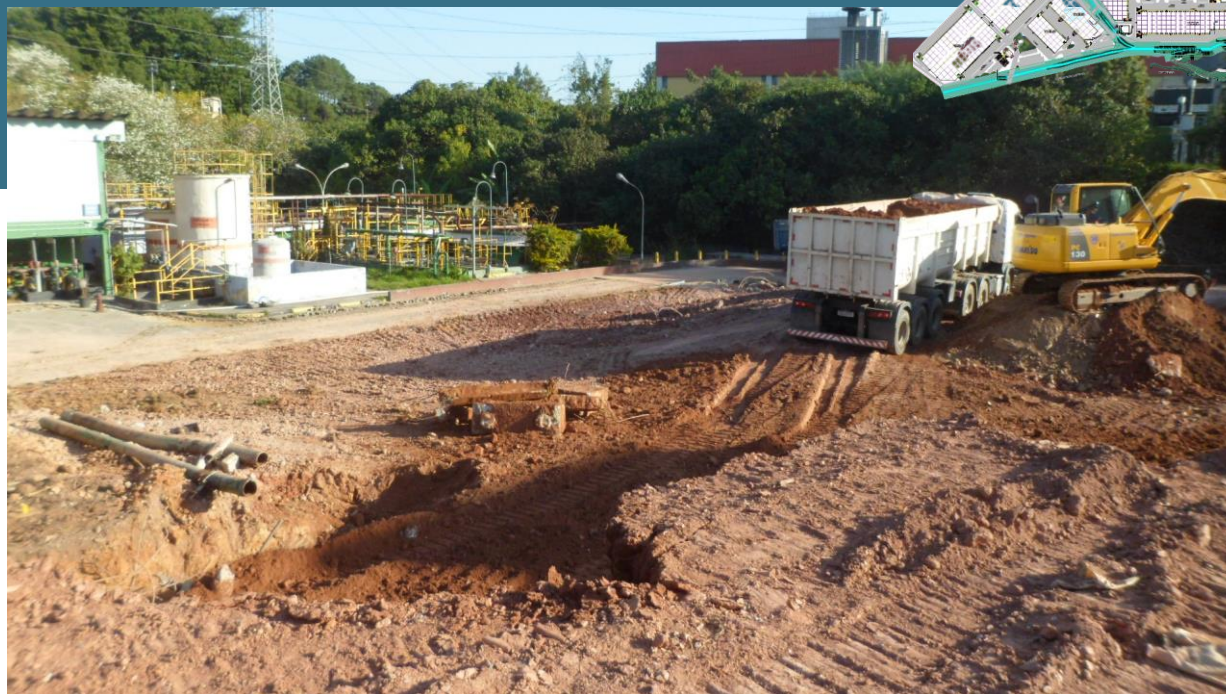
Vista do local em escavação, 04/07/2022
