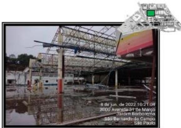
Demolição metálica - antigo prédio 34
