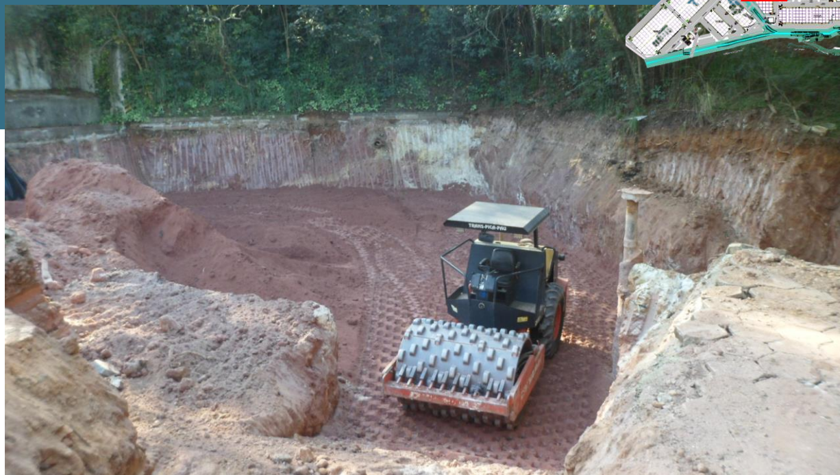
Detalhe: Aterro da cava até a altura de 2,0 metros, 04/07/2022
