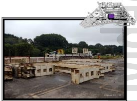
Demolição de estrutura metálica (Pits) - antigo prédio 16
