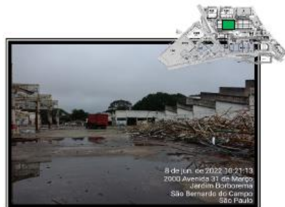
Demolição metálica - antigo prédio 35
