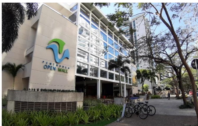
Imagem 2: Fachada – Península Open Mall
