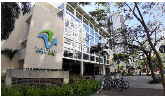
Imagem 2: Fachada – Península Open Mall
