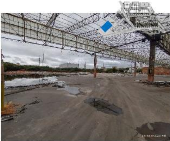
Demolição de estrutura – antigo prédio 93
