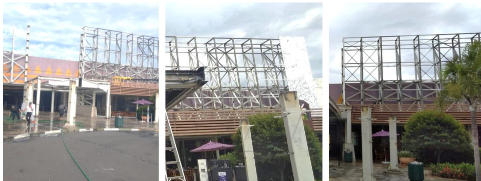
Em execução: Fachada
