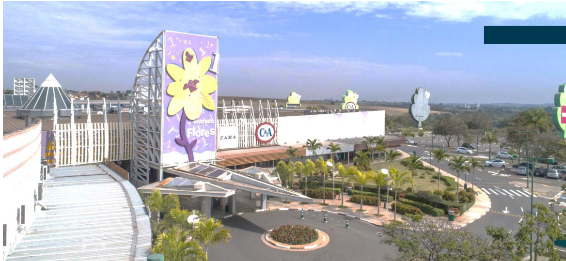
Antes x Perspectiva: Fachada
