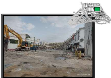
Demolição de estrutura metálica - antigo prédio 32
