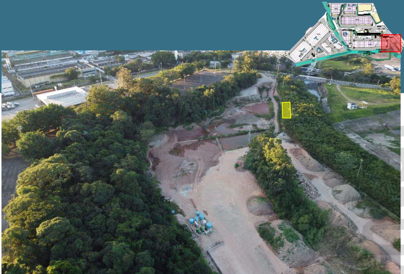
Pátio Vietnã, futuro prédio 1000 – 17/05/2022
