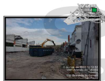
Organização e remoção de sucata - antigo prédio 32
