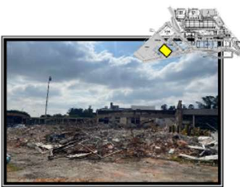
Demolição metálica - antigo prédio 94/95
