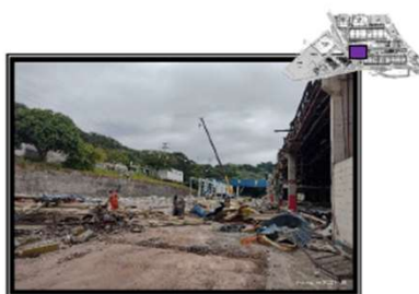
Demolição de estrutura metálica - antigo prédio 70
