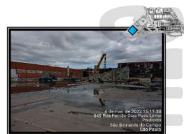
Demolição metálica - antigo prédio 101
