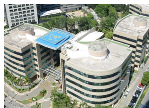
Edifício Millennium Office Park ABL: 4.410 m 2
