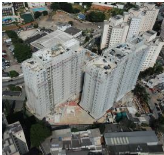
Foto Estrutura Obra
