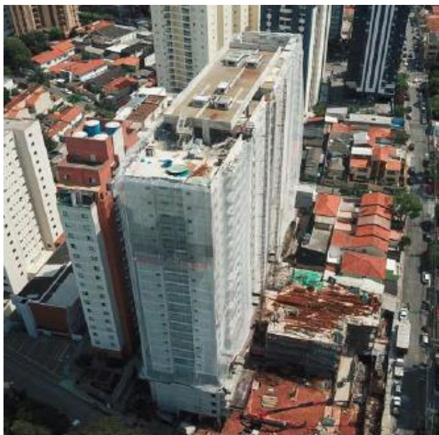
Foto Vista Geral Obra
