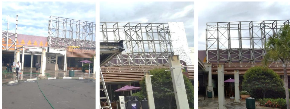
Em execução: Fachada
