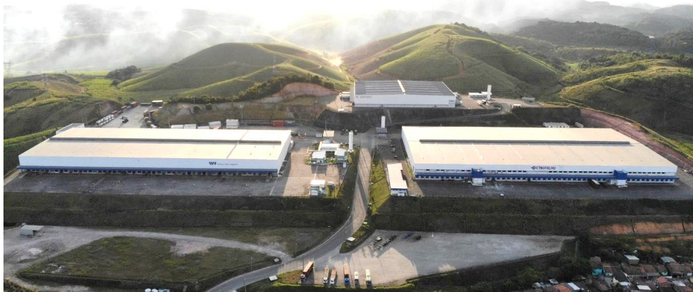
Imagem 3: Foto Aérea do Imóvel
