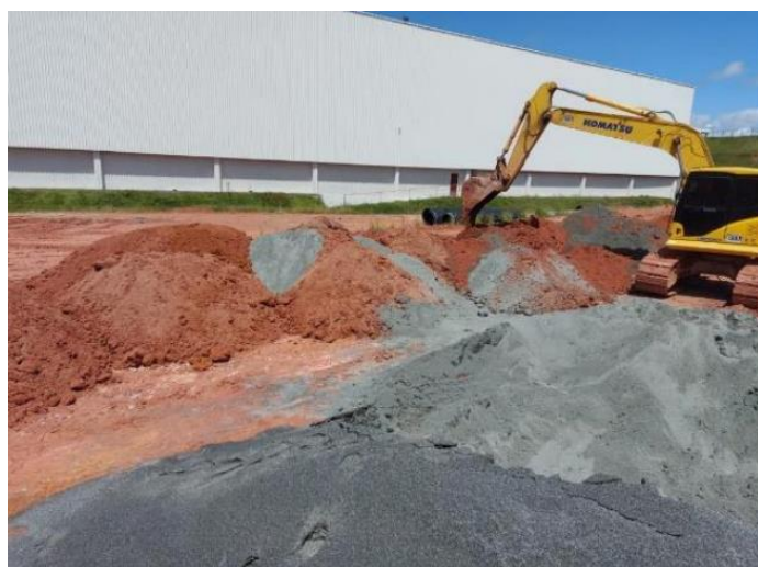
Imagem 8: Reparos no Talude
