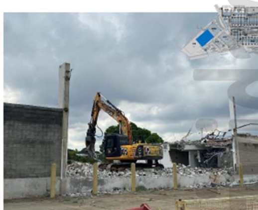
Demolição de alvenaria – antigo prédio 101
