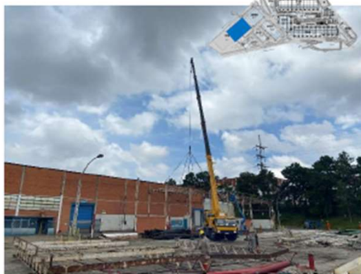
Demolição de estrutura metálica – antigo prédio 101
