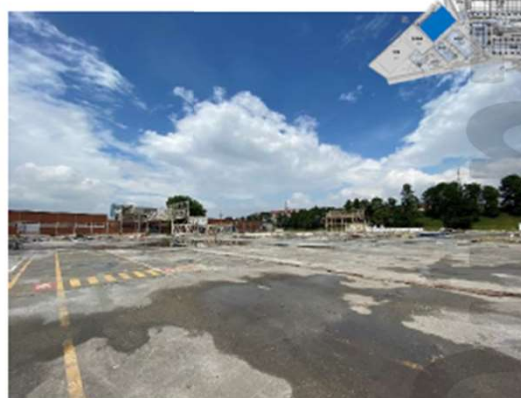
Demolição – antigo prédio 102
