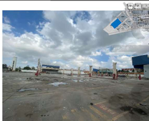
Demolição de estrutura metálica – antigo prédio 101
