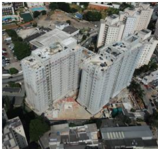
Foto Estrutura Obra
