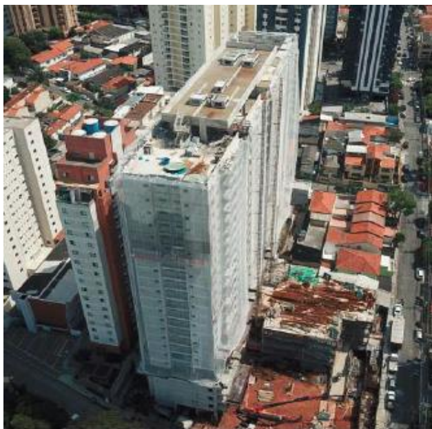
Foto Vista Geral Obra
