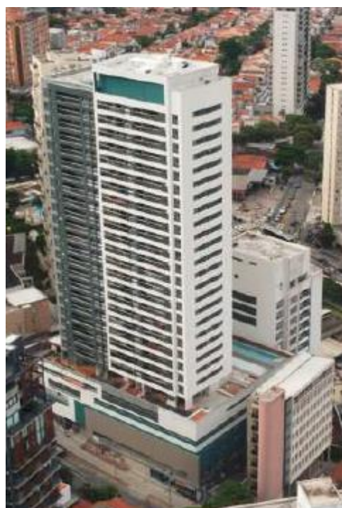
Foto Fachada da Obra - Misce
