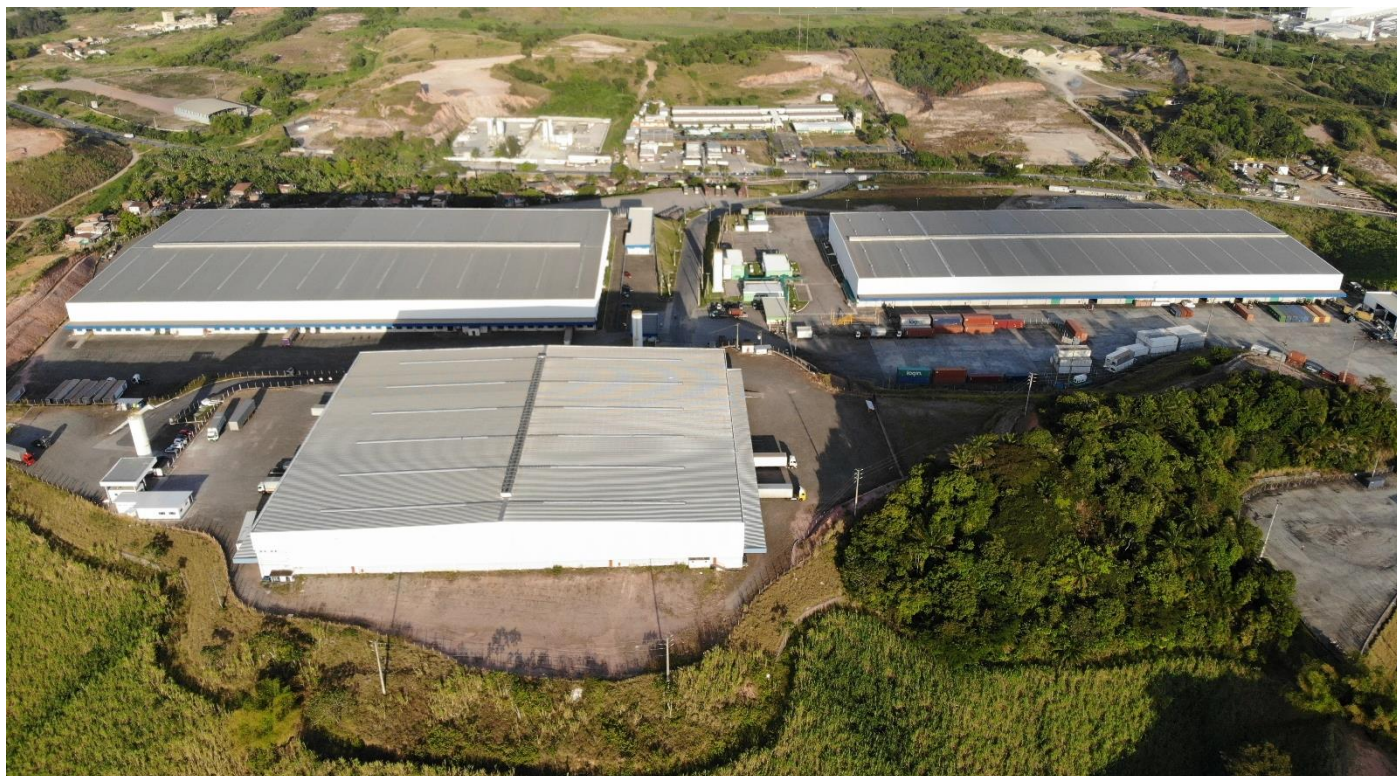
Imagem 5: Foto Aérea dos Galpões
