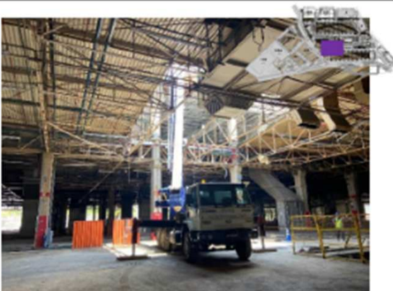
Remoção de subestação – antigo prédio 70
