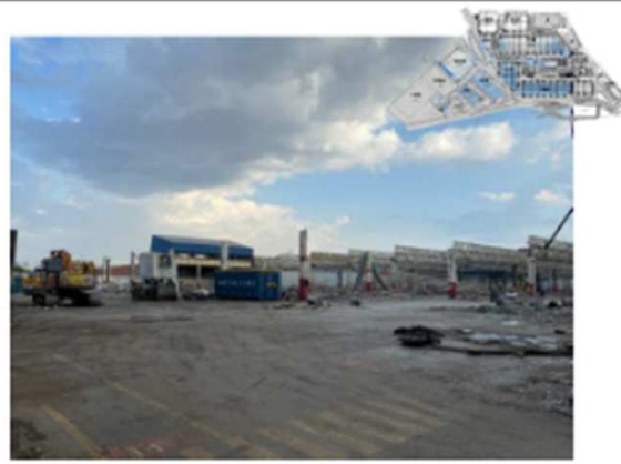
Demolição de estrutura metálica – antigo prédio 101
