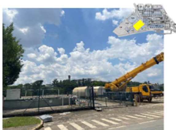
Remoção dos tanques – antigo prédio 90
