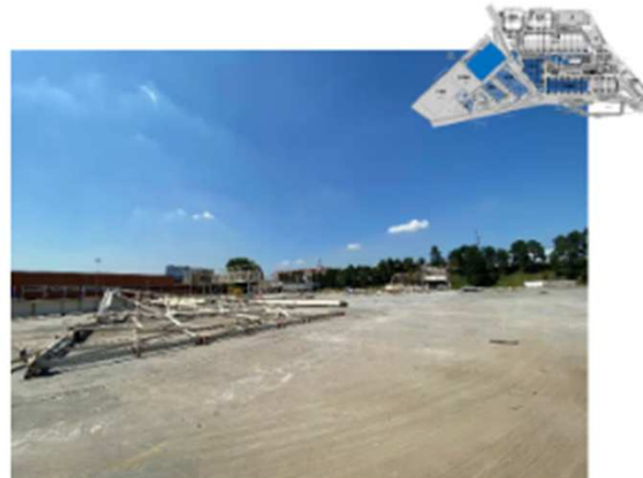
Demolição – antigo prédio 102
