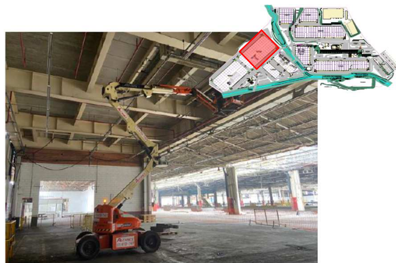
Remoção de subestação – antigo prédio 101
