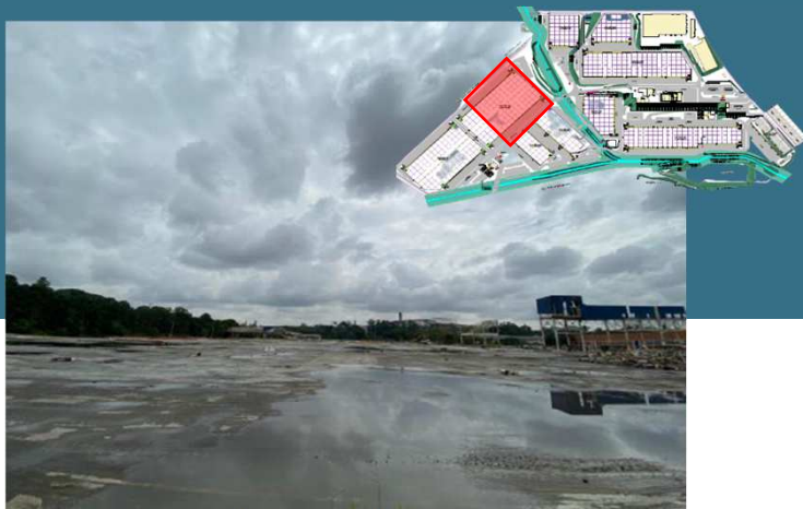
Demolição – antigo prédio 102
