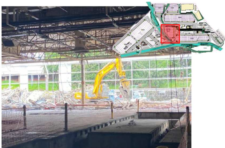
Demolição da estrutura metálica – antigo prédio 70
