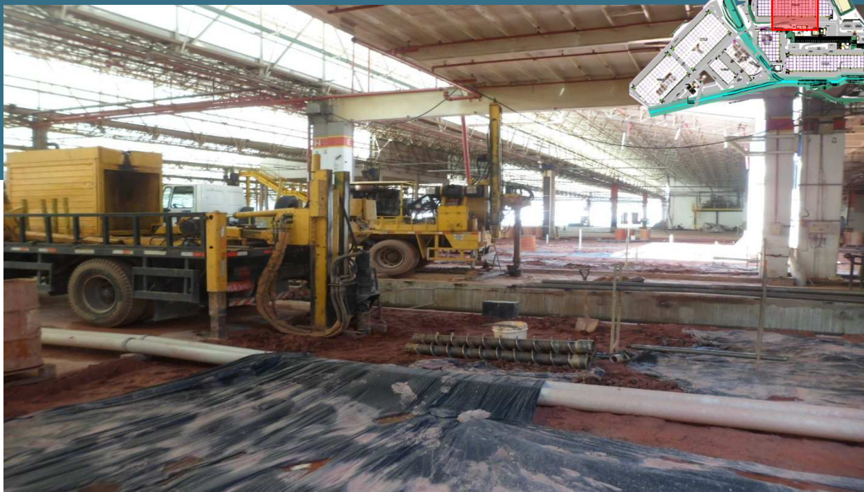
Atual Prédio 33, futuro prédio 700, aterro finalizado– 10/01/2022
