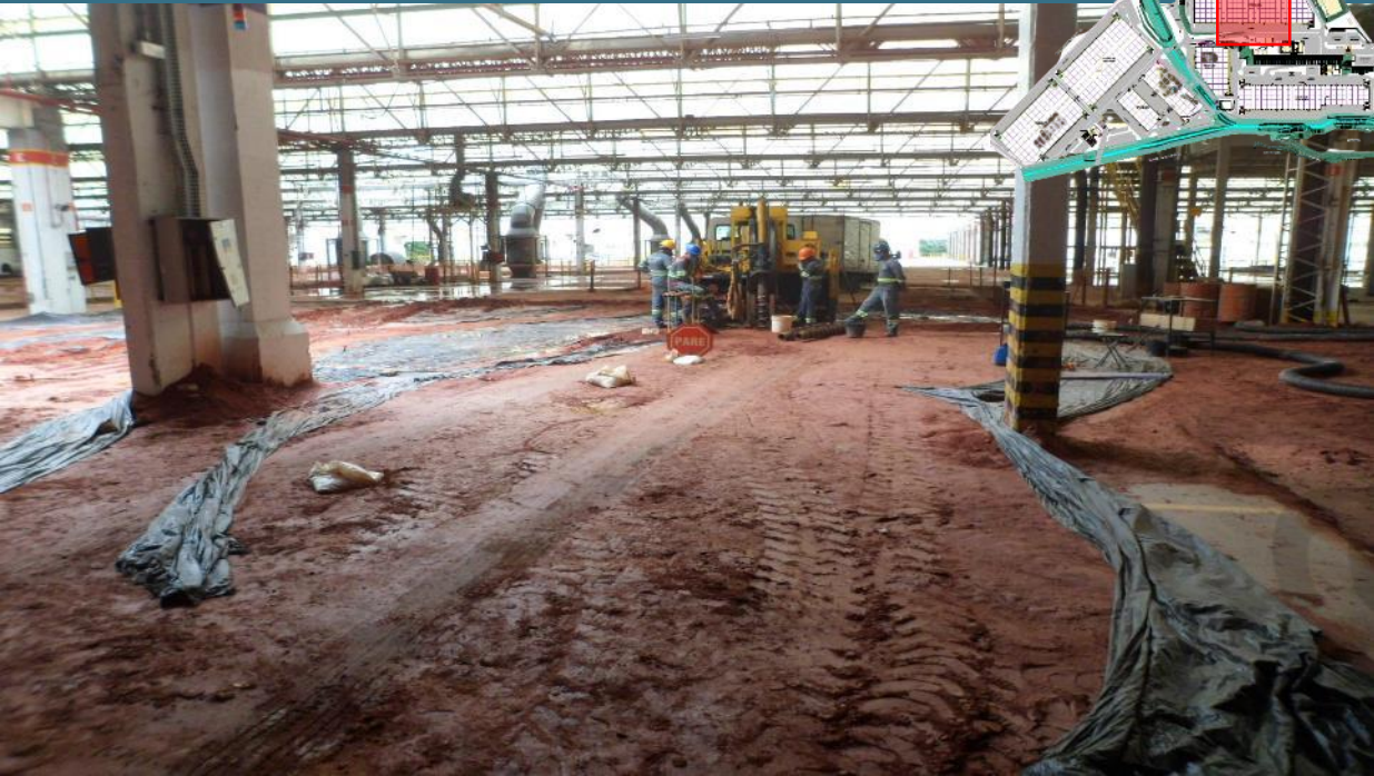
Atual Prédio 33, futuro prédio 700, aterro finalizado– 10/01/2022
