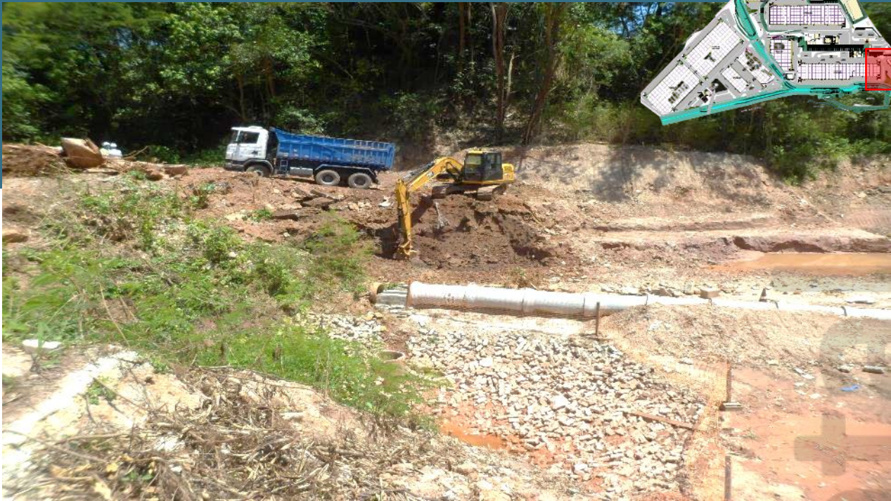
Pátio Vietnã, futuro prédio 1000 – 23/11/2021
