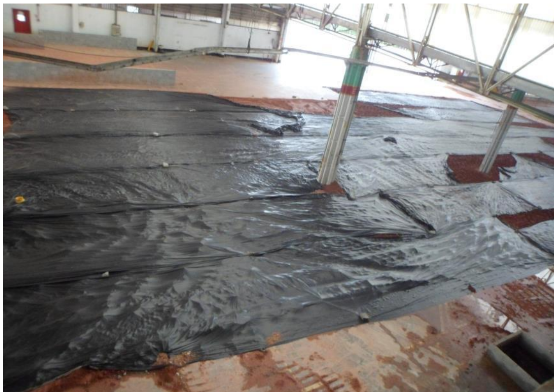
Atual Prédio 33, futuro prédio 700, aterro finalizado– 10/01/2022
