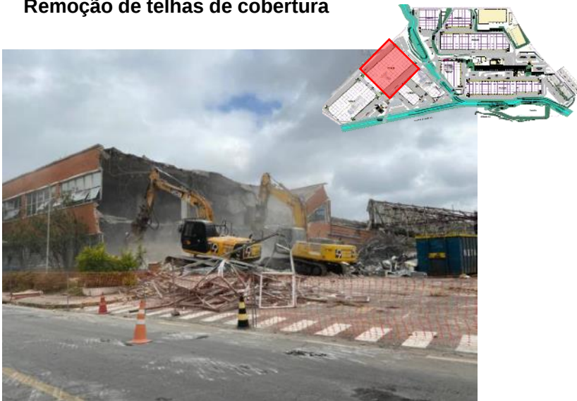
Demolição do antigo prédio 102
