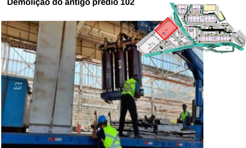
Desmontagem e remoção de subestações
