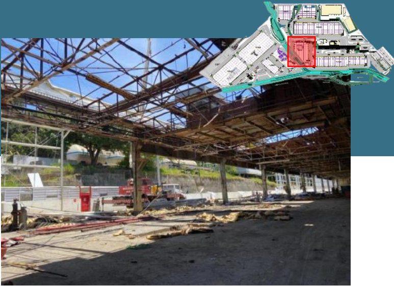
Remoção de telhas de cobertura
