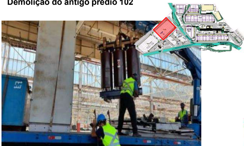
Desmontagem e remoção de subestações
