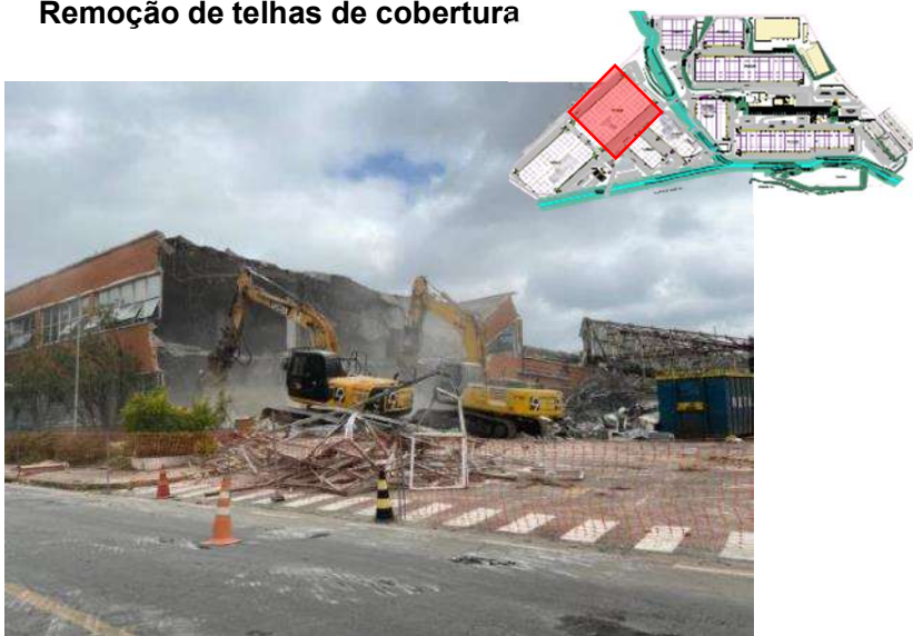
Demolição do antigo prédio 102
