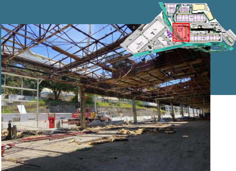
Remoção de telhas de cobertura
