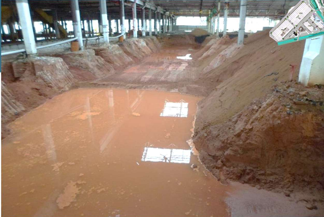
Atual Prédio 33, futuro prédio 700, Escavação paralisada pelas chuvas – 23/10/2021
