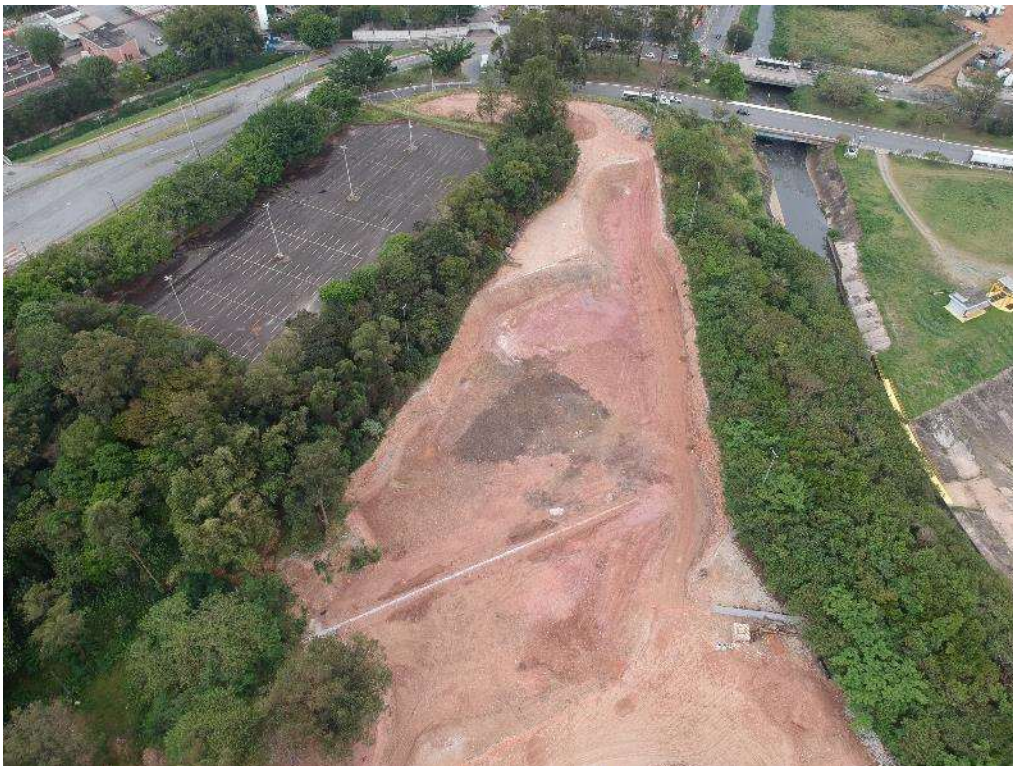
Pátio Vietnã, futuro prédio 1000 – 06/10/2021
