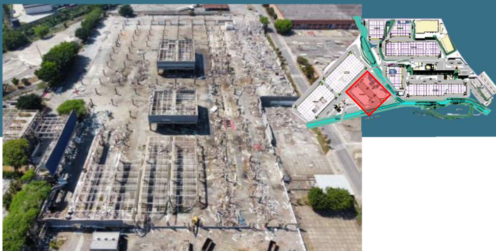
Demolição mecanizada do antigo prédio 90 (Futuros Galpões 300 e 400)
