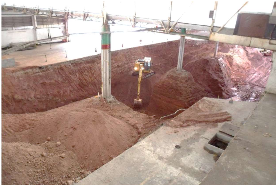
Atual Prédio 33, futuro prédio 700, Escavação em Curso – 05/10/2021
