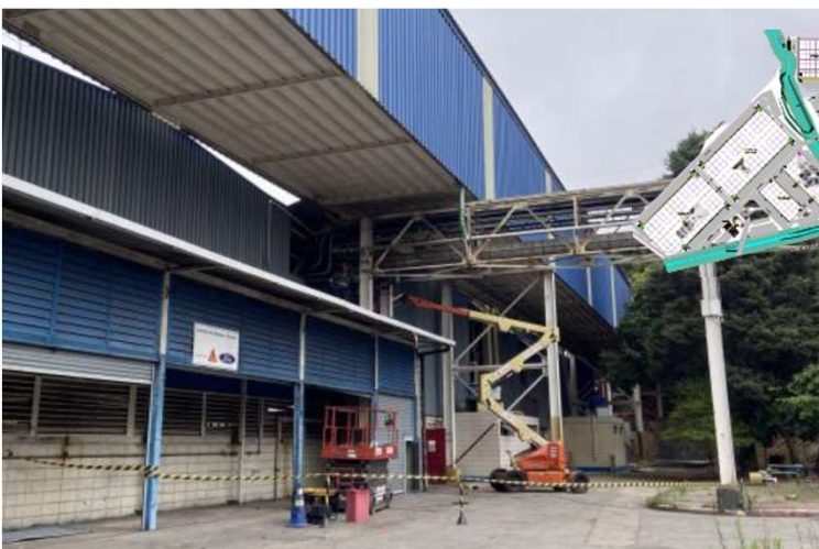
Remoção dos cabos do antigo prédio 70 (Futuro Galpão 800)
