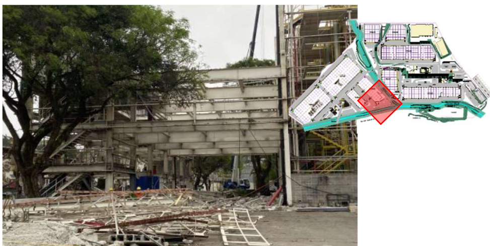
Demolição do antigo prédio 400 (Futuro Galpão 400)
