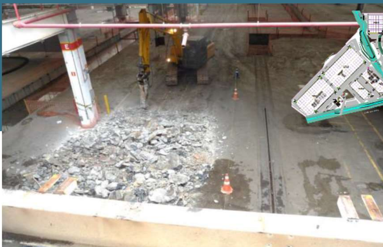
Quebra de piso do antigo prédio 33 (Futuro Galpão 700)
