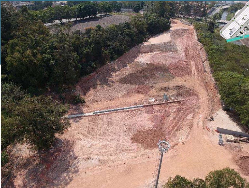
Pátio Vietnã, futuro prédio 1000 – 08/09/2021
