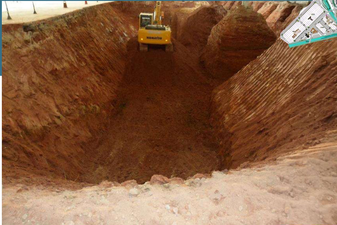
Atual Prédio 33, futuro prédio 700, Escavação em Curso– 05/10/2021
