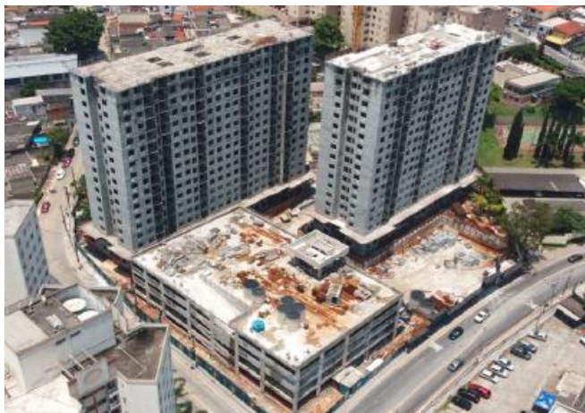
Foto Estrutura Obra
